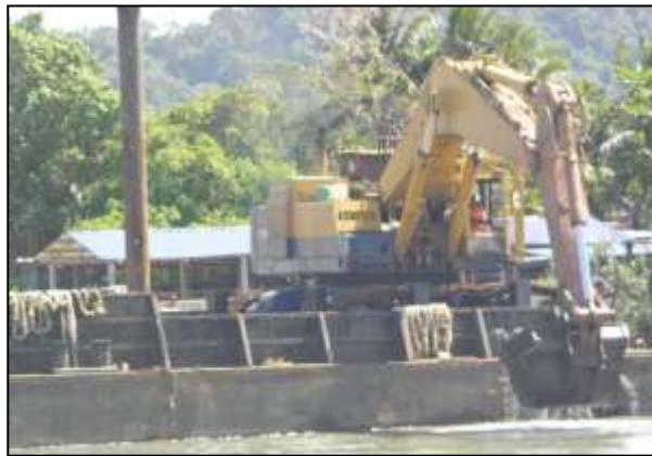
Figure 3. Backhoe dredger (Kuala Perlis, Perlis)
