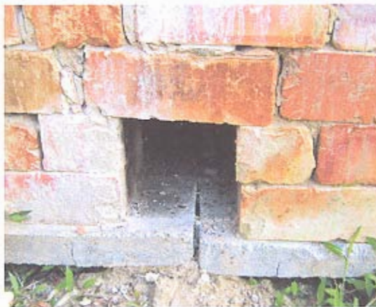
Membuat lubang untuk menyalurkan gas
