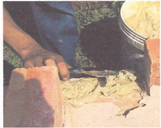
Meletakkan campuran tanah dan pasir ke atas batu-batu
